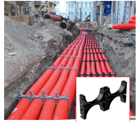
Рис. 1. Застосування кластерів для багаторівневої кабельної каналізації.
