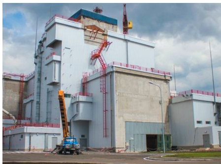
СВЯП-2, Чорнобильська АЕС SFSF-2 (spent fuel storage facility), Chornobyl NPP
