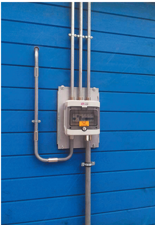
Котеджне містечко в Пущі Водиці. Монтаж кабельної системи згідно вимог ПУЕ 2.1.19 Cottage town in Pushcha Vodytsia. Installation of cable system according to the EIC 2.1.19 requirements
