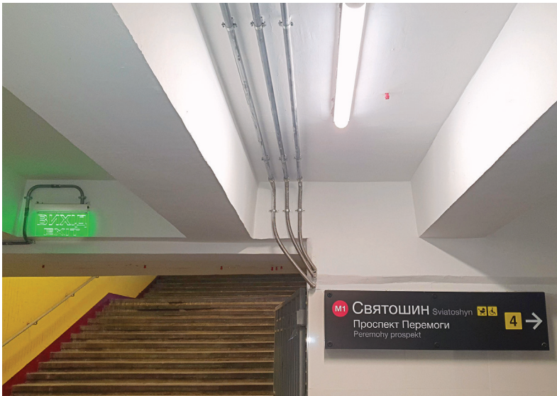
Метро «Святошин» побудова вандалостійкої мережі освітлення та сповіщення Sviatoshyn metro station. Construction of a tamper-proof lighting and public-address system
