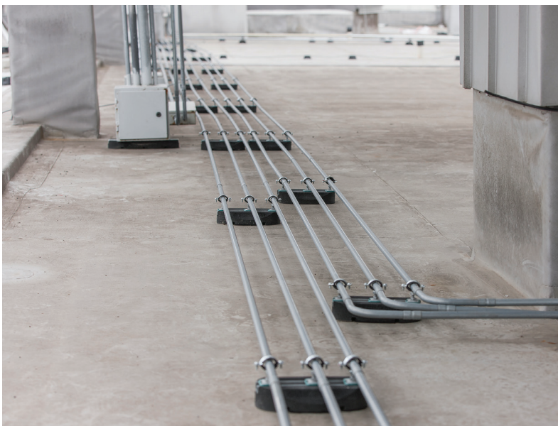
Монтаж кабельних ліній на плоскому даху будинка Installation of cable lines on the flat roof of the building
