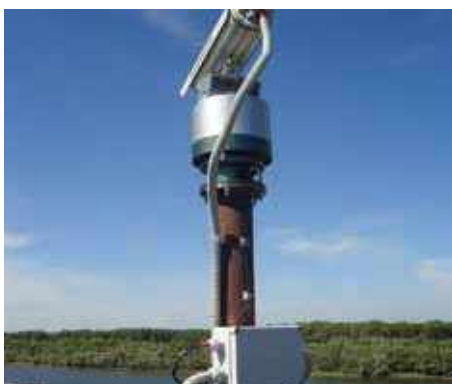
Відеоспостереження Захист проводів живлення камер вуличного відеоспостереження CCTV Protection of power wires for outdoor cameras
