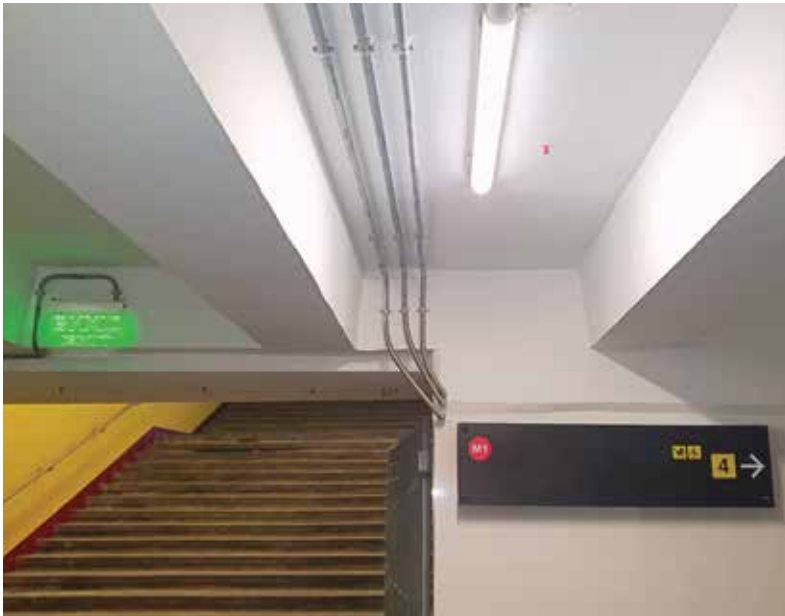
Побудова вандалостійкої мережі освітлення та сповіщення Construction of a tamper-proof lighting and public-address system
