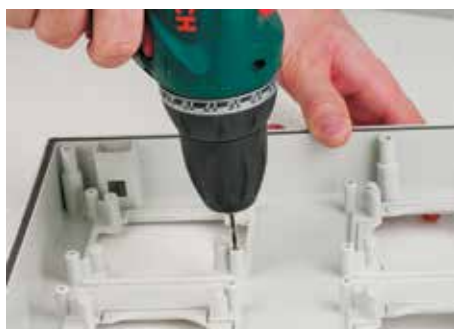
Розетка встановлюється на нові посадкові місця. Заблоковані за замовчуванням отвори для зручності встановлення необхідно наскрізь просвердлити (діаметр свердла – 3 мм) Отвір непотрібний для розетки з фланцем 70x87 мм (DIS5706407 та ін.) The socket is installed on new slots. The holes blocked by default should be drilled through for ease of installation (drill diameter is 3 mm) The hole is unnecessary for a socket with a 70x87 mm collar (DIS5706407, etc.)
