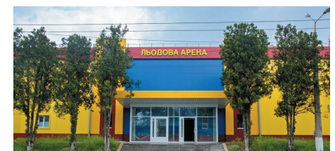
Льодова Арена, м. Краматорськ, Донецької області Ice Arena, City of Kramatorsk, Region of Donetsk
