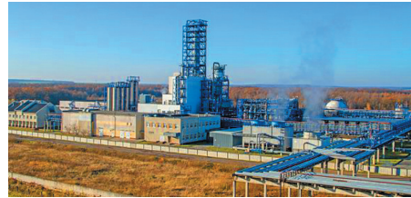
Завод Карпатнафтохім (головний корпус) Karpatnaftochim Plant (main building)
