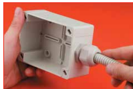
Етап 3. Введення труби і кабелю Step 3. Insertion of pipe and cable
