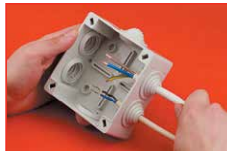
Етап 3. Введення кабелю Step 3. Insertion of cable
