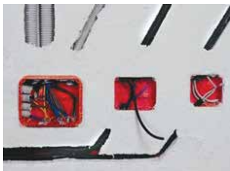
Приховане прокладання в штробах стін, технічних шахтах, пустотах будівельних конструкцій Hidden laying in wall grooves, technical shafts, voids of building structures
