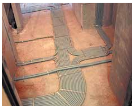
Приклади монтажу гофрованої труби з ПВХ (серія 9) Examples of installation of PVC corrugated pipes (series 9)
