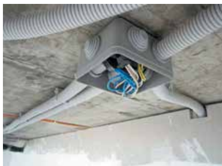
Приховане прокладання в пустотах фальшстель Concealed installation in voids of false ceilings
