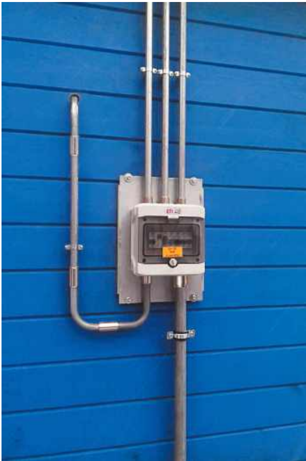
Монтаж кабельної системи згідно вимог ПУЕ 2.1.19 Installation of cable system according to the EIC 2.1.19 requirements
