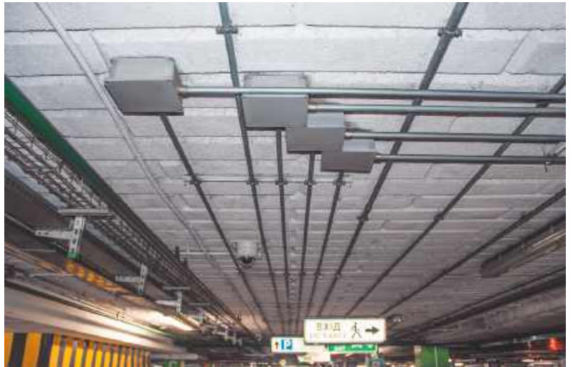
Паркінг. Системи для прокладання кабелю із захистом IP67 Parking. IP67 cable support systems
