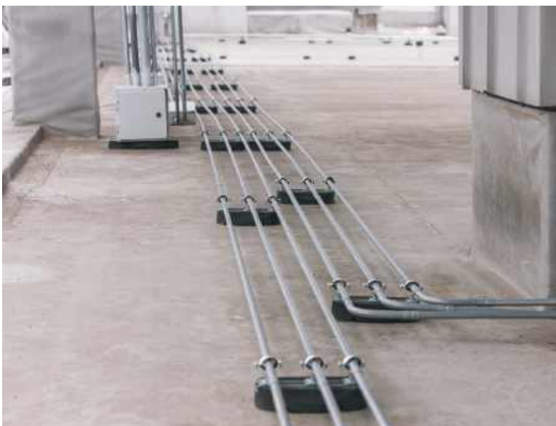
Монтаж кабельних ліній на даху будинка Installation of cable lines on the roof of the building
