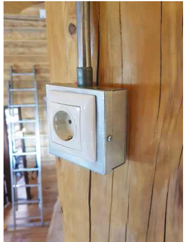
Котеджне містечко. Монтаж кабельних систем по легкозаймистим конструкціям відповідно до вимог ПУЕ Cottage town. Installation of cable systems on combustible structures in accordance with the EIC requirements
