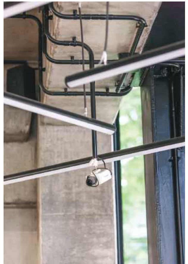
Монтаж лінії відеонагляду в електротехнічних трубах для захисту від електромагнітних перешкод Installation of CCTV in EMI-protected electrical pipes
