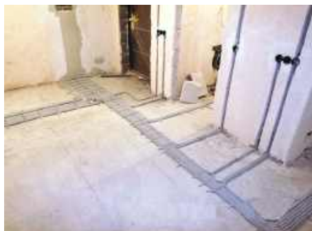
Приховане прокладання при заливанні в бетон, у стяжках підлог Concealed laying when casting in concrete, in floor screeds
