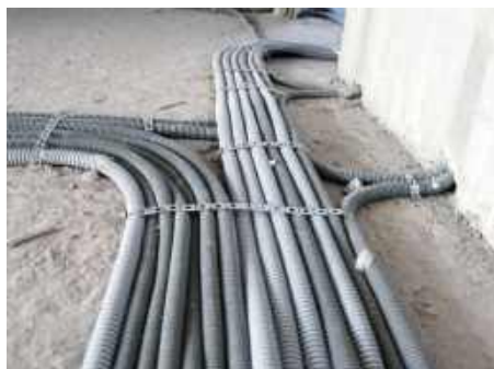
Приховане прокладання при заливанні в бетон, у стяжках підлог Concealed laying when casting in concrete, in floor screeds
