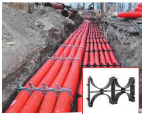
Рис. 1. Застосування кластерів для багаторівневої кабельної каналізації. Fig. 1. Application of clusters for multilevel cable duct.
