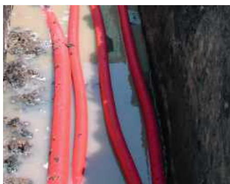
Рис. 1. Застосування кластерів для багаторівневої кабельної каналізації. Fig. 1. Application of clusters for multilevel cable duct.
