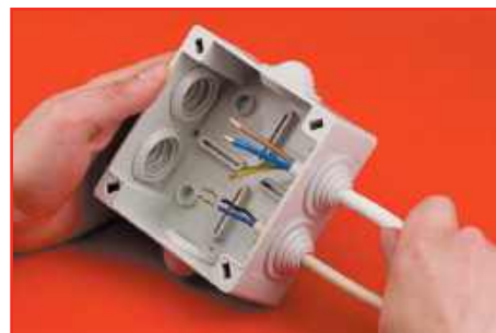
Етап 3. Введення кабелю Step 3. Insertion of cable
