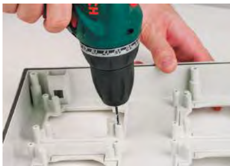
Розетка встановлюється на нові посадкові місця. Заблоковані за замовчуванням отвори для зручності встановлення необхідно наскрізь просвердлити (діаметр свердла – 3 мм) Отвір непотрібний для розетки з фланцем 70x87 мм (DIS5706407 та ін.) The socket is installed on new slots. The holes blocked by default should be drilled through for ease of installation (drill diameter is 3 mm) The hole is unnecessary for a socket with a 70x87 mm collar (DIS5706407, etc.)
